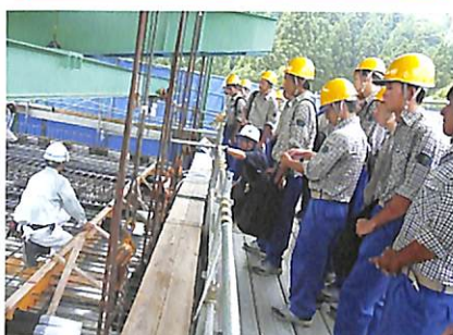
道路建設工事の現場見学
